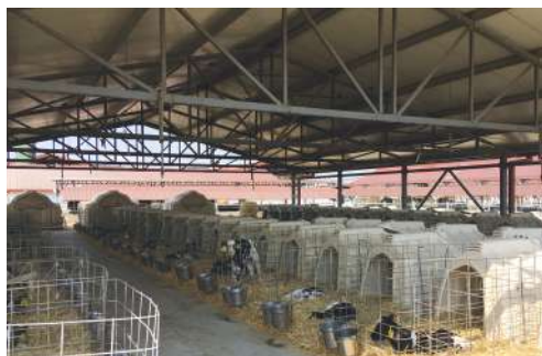
4. Hőszigetelt tetőzet borjak felett
